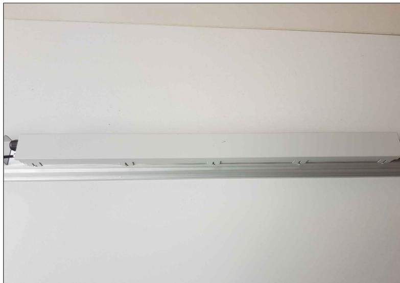
3) Verschraubung der Treibereinhausung lösen
